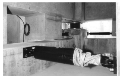
(ت) میراگر ویسکوز
