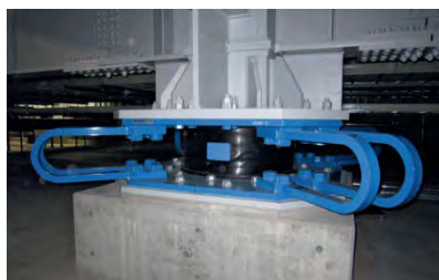
(ب) میراگر تسلیمی فولادی U-شکل
