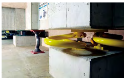
(ج) میراگر تسلیمی سربی و تسلیمی فولادی
