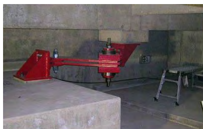
(پ) میراگر اصطکاکی
