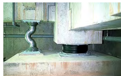
(الف) میراگر تسلیمی سربی
