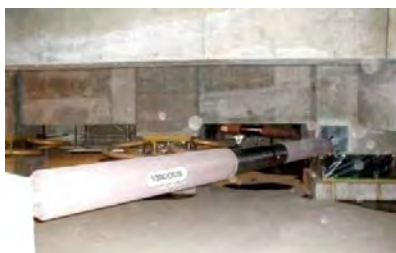
(ث) میراگر ویسکوز و تسلیمی فولادی
